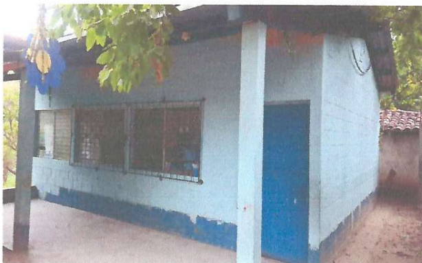
Foto1: Piso y puerta de aula No. 1
