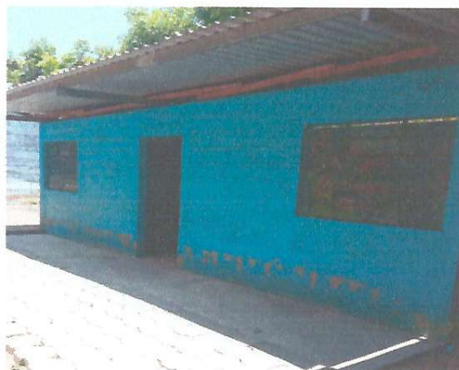
foto 2: Ventanas, balcones y puerta de aula No. 2
